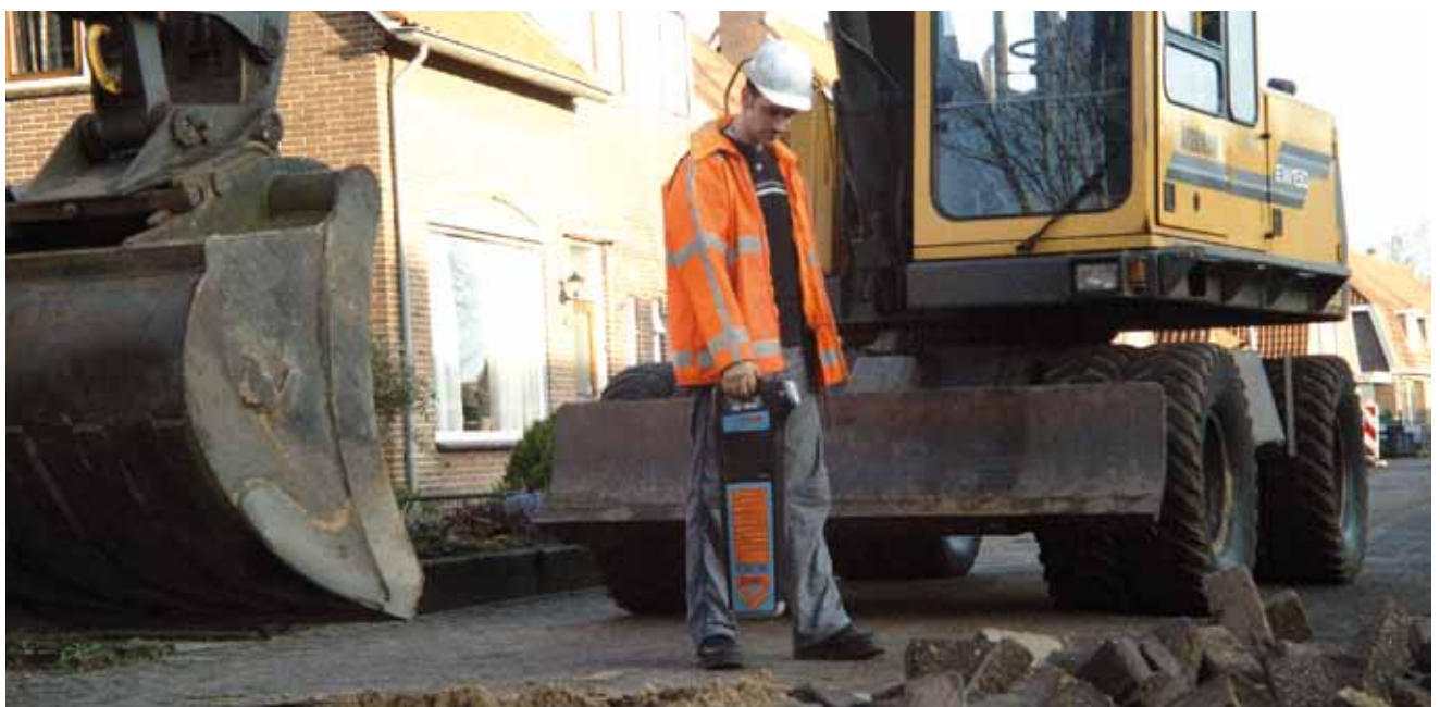
Goed werk begint met vooraf kabels en leidingen opsporen. ►
